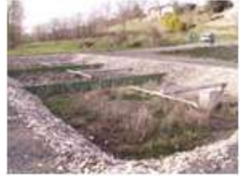
Station d'épuration de Vieux
