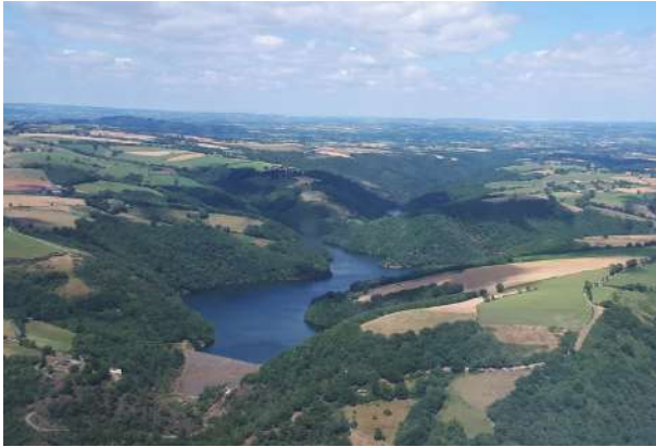
Le barrage de Saint-Géraud
