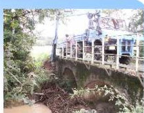
Enlèvement d'embâcles obstruant un pont (Castelnau de Montmiral)
